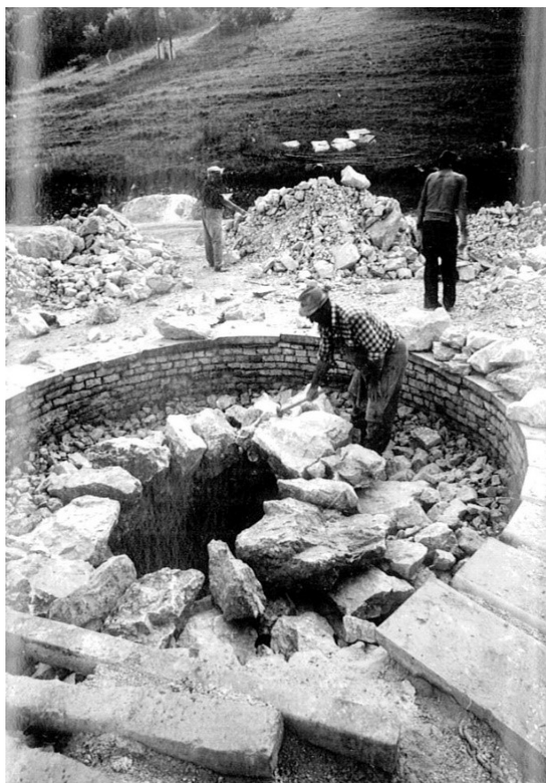
Mészgödör, mészkemence építése az 1970-es évek végén a Bükkben. A képen Halász László és munkatársai láthatók. (Halász László családi fotóarchívumából)
